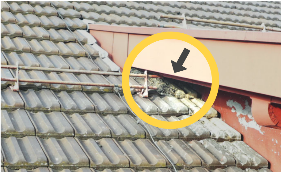
Die Kamera hält Positionen wie hier fest, wo sich Tauben Zugang zum Dachstock des Gebäudes verschafft hatten. Sie wurden anschliessend mit einer neuen Gitterkonstruktion versperrt.
